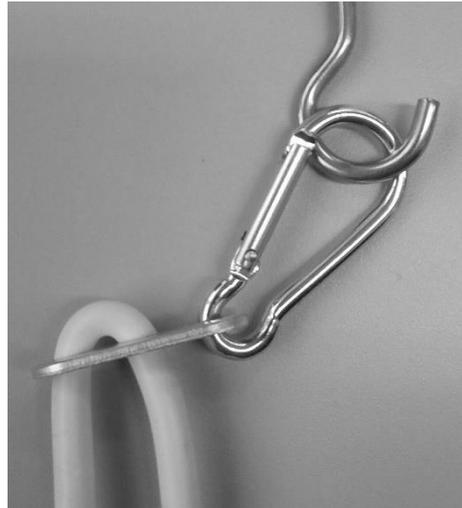
4. Prenez l'élingue de sécurité en acier du câble de la ligne d'enceinte et faites-la passer dans le clip de fixation comme représenté dans la photo.
