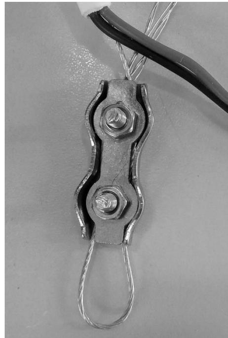
5. Pour que l'installation soit totalement sécurisée, accrochez également l'élingue de sécurité au crochet fileté.
